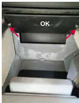
Obr. 23 - Pohled na přepážku ze spalovací komory
